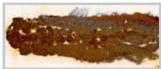
BEZ Allgrund: Brak ochrony antykorozyjnej
